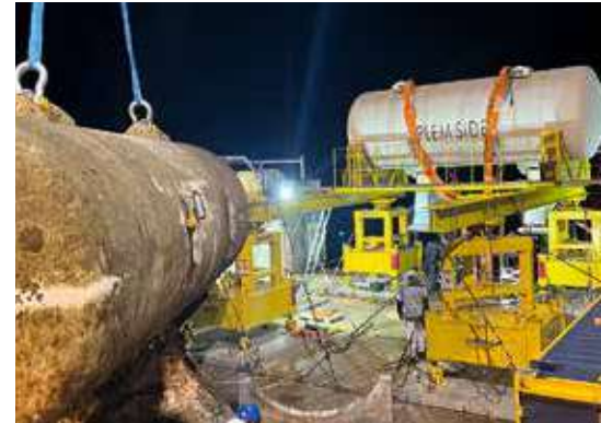
Момент подъема старого ТП, и подготовка к погружению нового / Фото: АО «Белуга Проджектс Логистикс»
