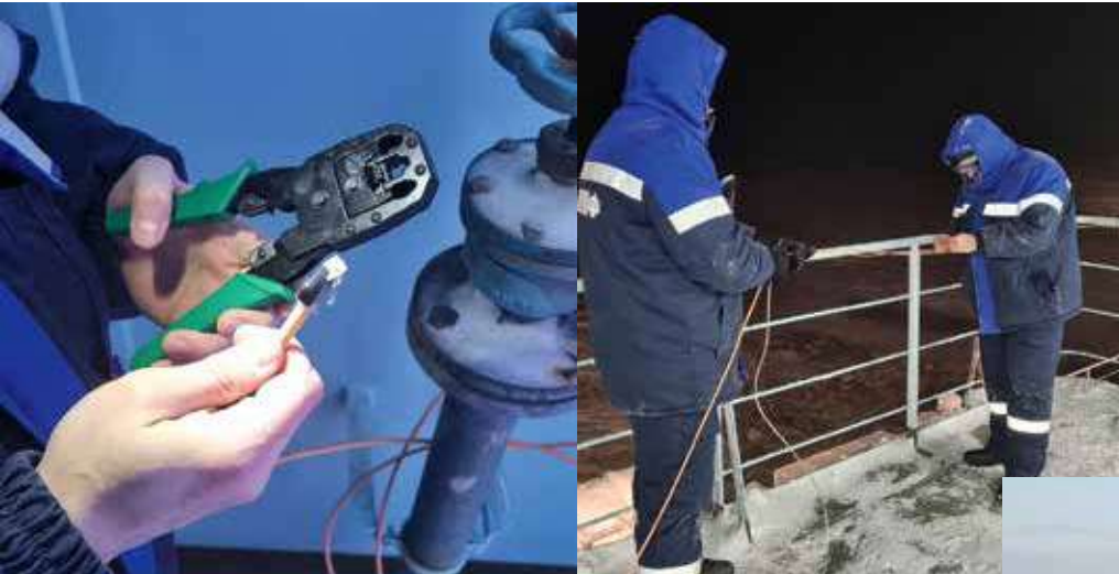
Монтаж информационно-измерительного комплекса на борту «Урала» / Фото: АО «ЦНИИМФ»
